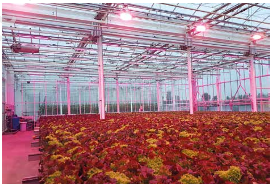
Op het PSKW werd een deel van een serre met MGS uitgerust met watergekoelde leds (vooraan) en een deel met luchtgekoelde leds (achteraan). Tijdens de energiedoormeting was het tussenscherm continu naar beneden.
